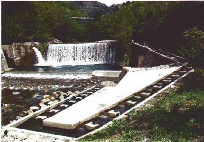
巨大な階段のような水路を上るように魚道が設計された二間手砂防えん堤。中央の魚道入り口が砂利で埋まっている=いずれも郡上市の吉田川で
