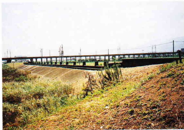
写真-1 右岸上流から見た洗堰
