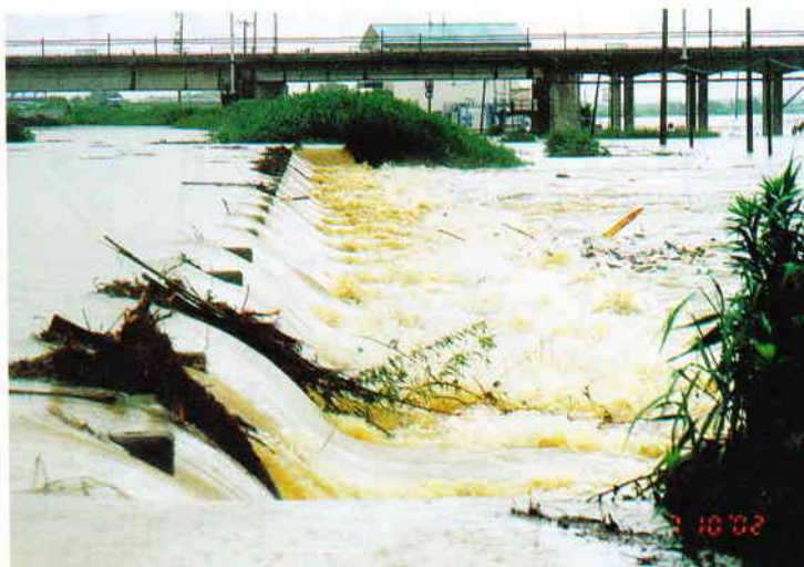
写真-2 洗堰からの越流状況 (平成14年7月10日)
