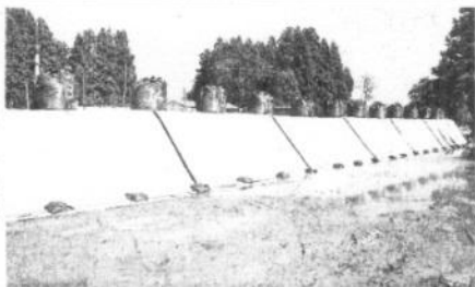
土嚢で仮設された堤防。右側奥に雄物川が流れている。秋田県大仙市
