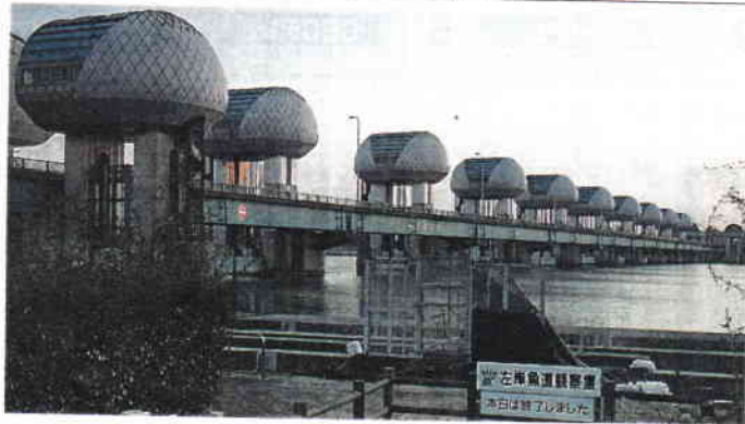
長良川河口堰。堰を越えるアユなどの遊上をガラス窓越しに見る魚道観察室もある。27日、三重県桑名市
